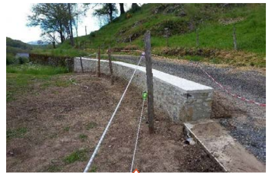
Réfection d'un mur de soutènement à Ydes Bourg
